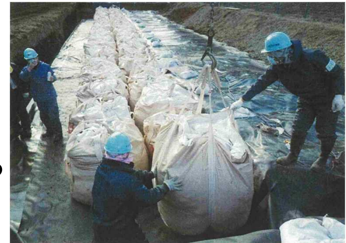
除去土壌の保管時の状況
