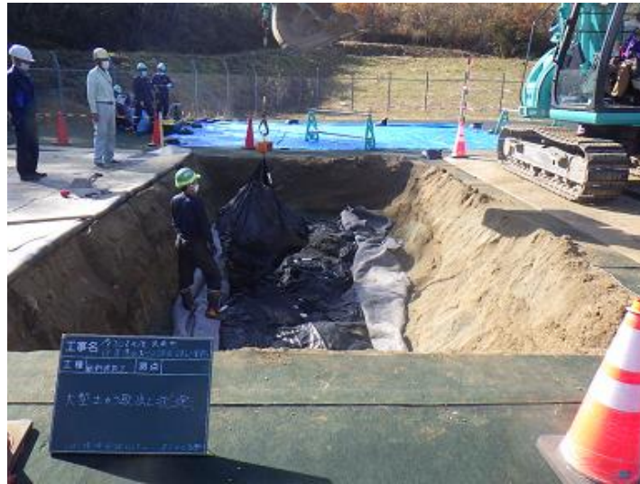
除去土壌等取り出し
