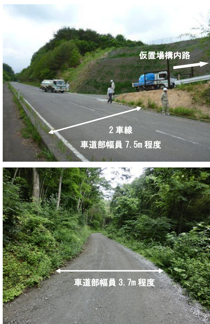
図12 仮置場へのアクセス道路の状況（例）
