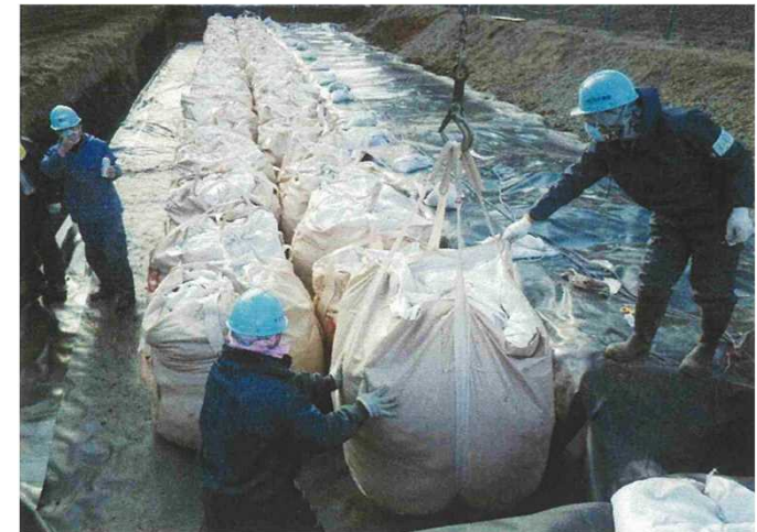
除去土壌の保管時の状況
