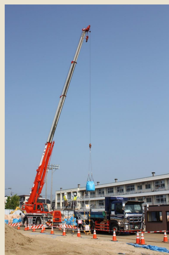
クレーンを使い除染土壌等をトラックに積み込む様子。
