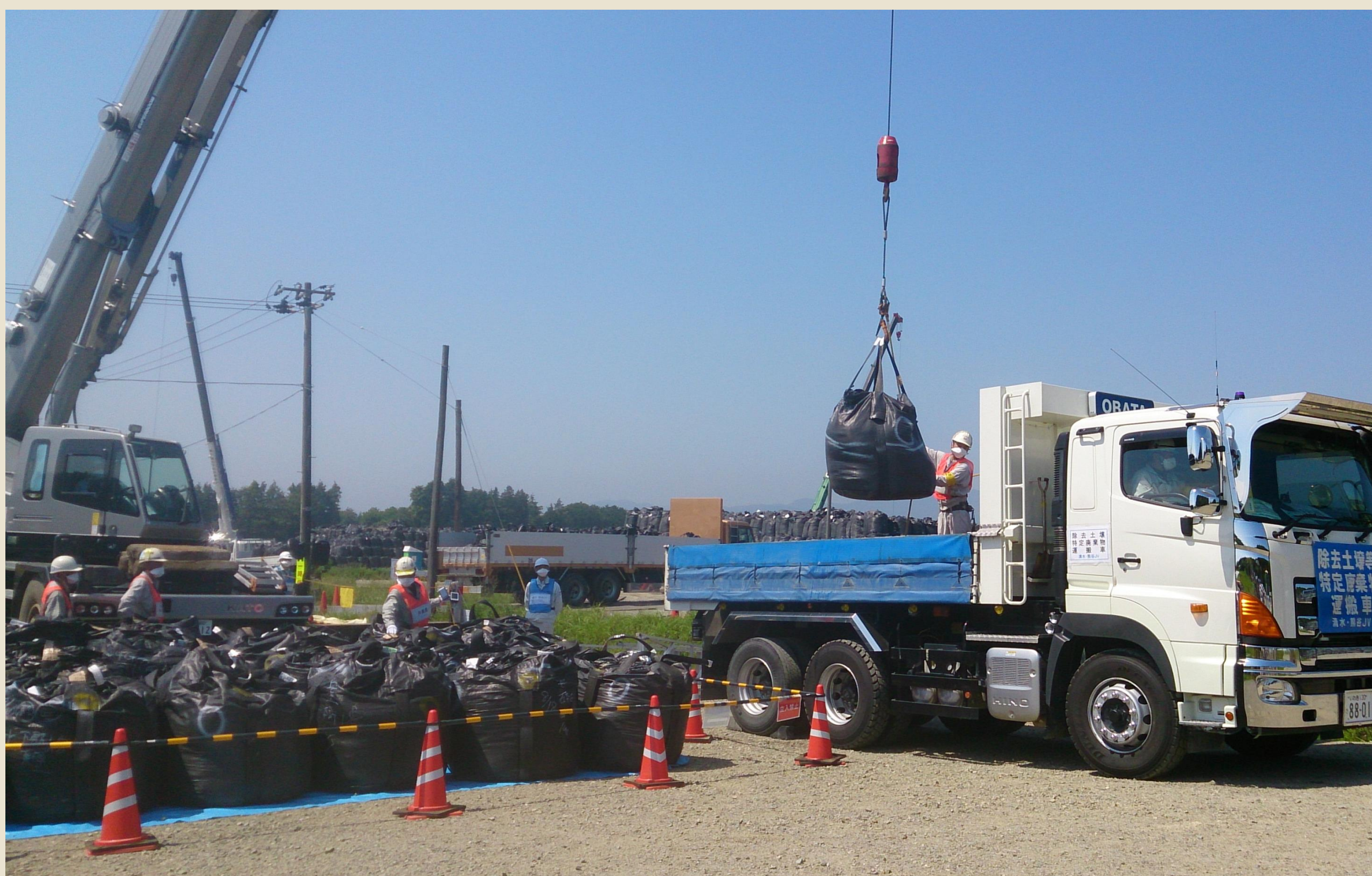
仮置場（積込場）でクレーンを使い除染土壌等を丁寧にトラックに積み込む様子。
