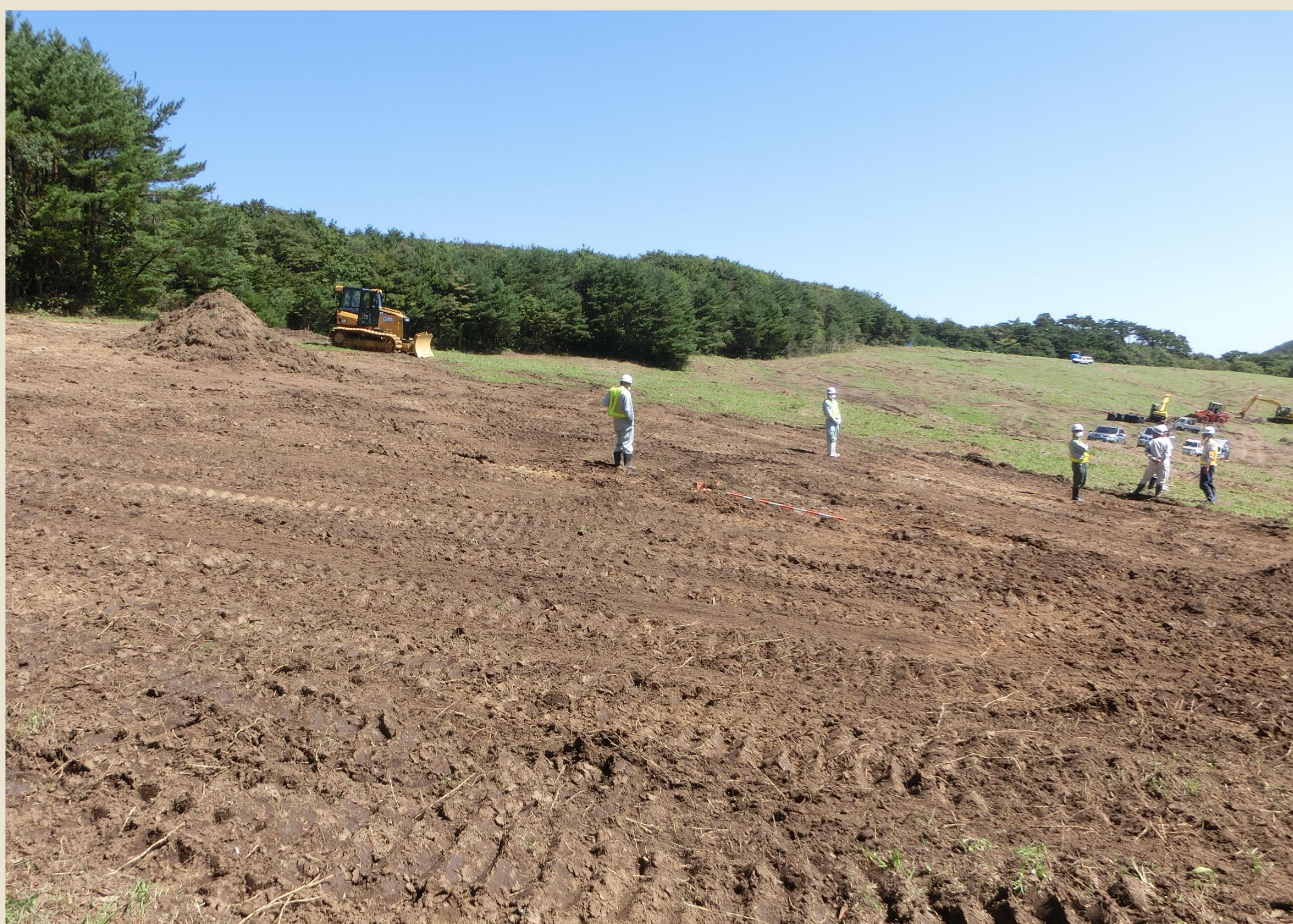
メガソーラー発電所建設予定地で、表土はぎ取りを行う除染作業員。
