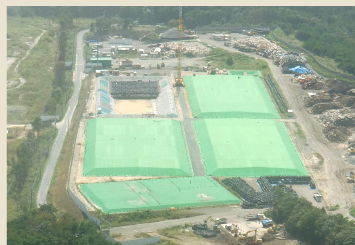
広野町の仮置場は半地下保管型。全4基中、3基への除染による除去物の搬入が完了している。
