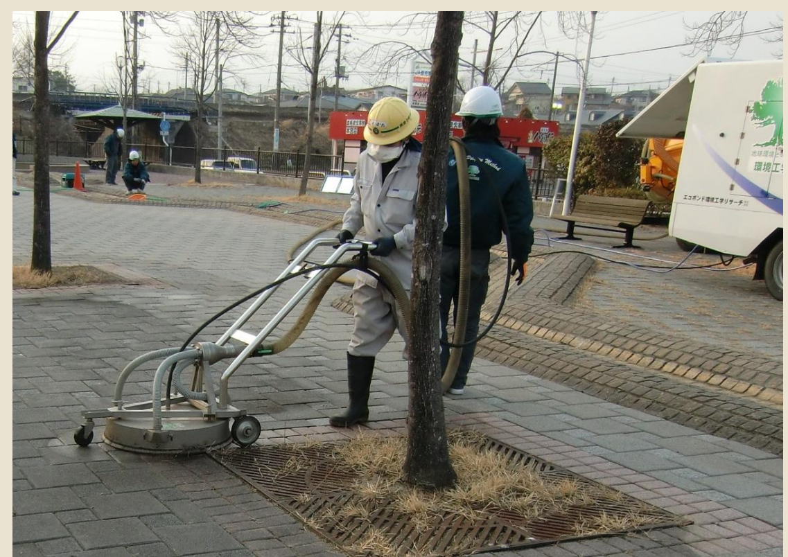
住民の憩いの場であるみずいろ公園（本宮市）を除染している様子。
