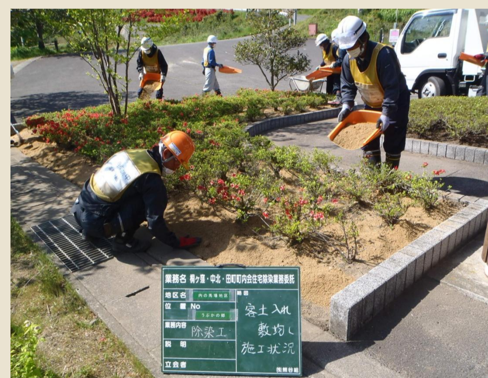
うぶかの郷敷地除染の様子。駐車場など植栽の土を除去し、新しい土を客土した。
