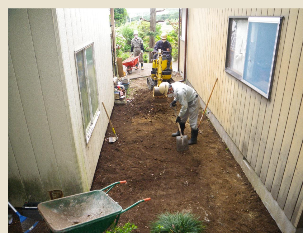
平成24年6月から8月にかけて、久之浜・大久地区の住宅で試験的に実施された除染作業で、表土の入れ替えを行う作業員。
