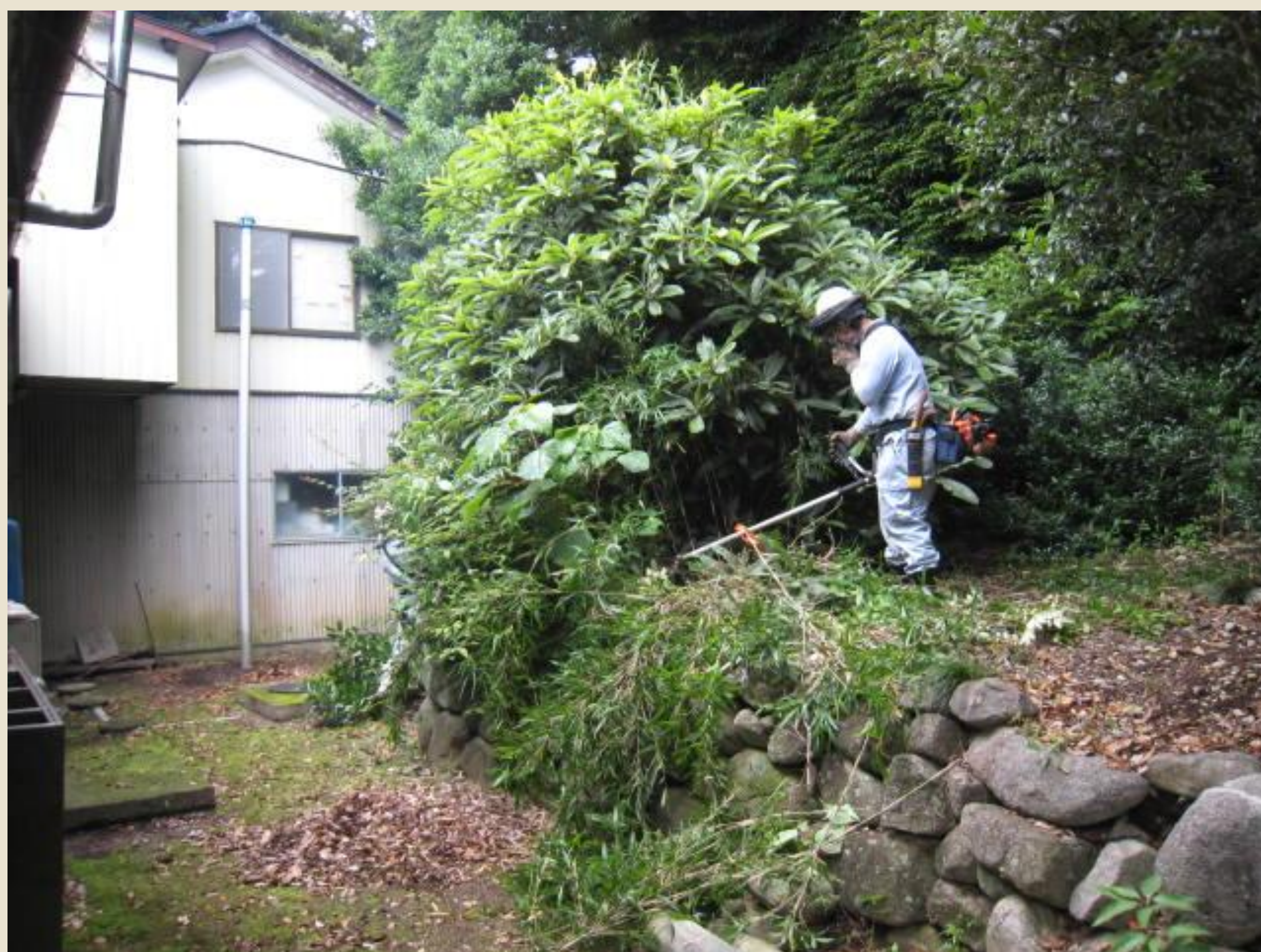
試験的に除染を実施した住宅において、樹木の枝打ちや落葉等の除去を行っている様子。
