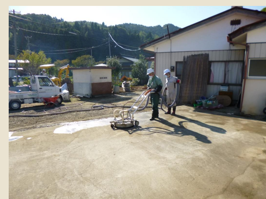
大里南部の沢邸地区住宅地の除染風景（平成24年10月撮影）
