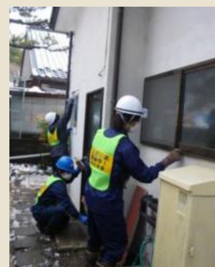
渡利地区で行っている住宅除染。屋根・壁の除染は、その材質、汚染の状況に応じ、手作業による堆積物の除去後、ふき取りや洗剤を使用してのブラッシング洗浄（苔、カビを重点的に除去）を実施。
