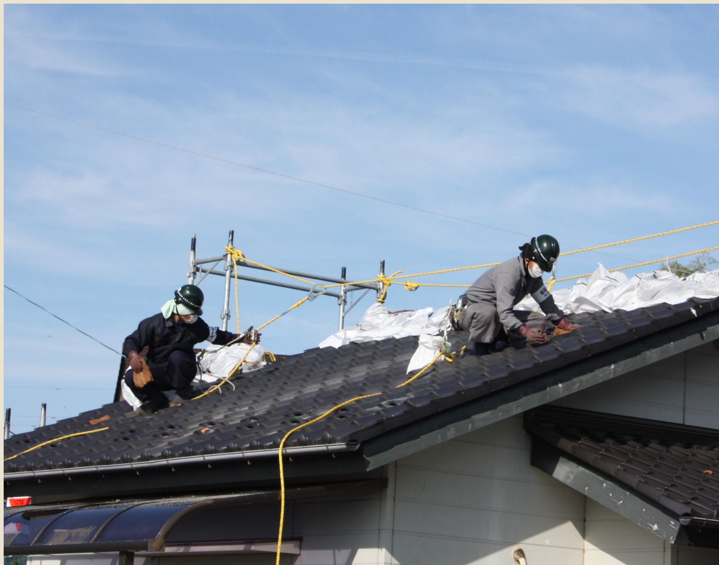
10月25日、上繁岡地区の住宅で行われた屋根の除染作業。 作業員が手作業で、水に濡らした紙タオルで瓦を拭き取っていきます。
