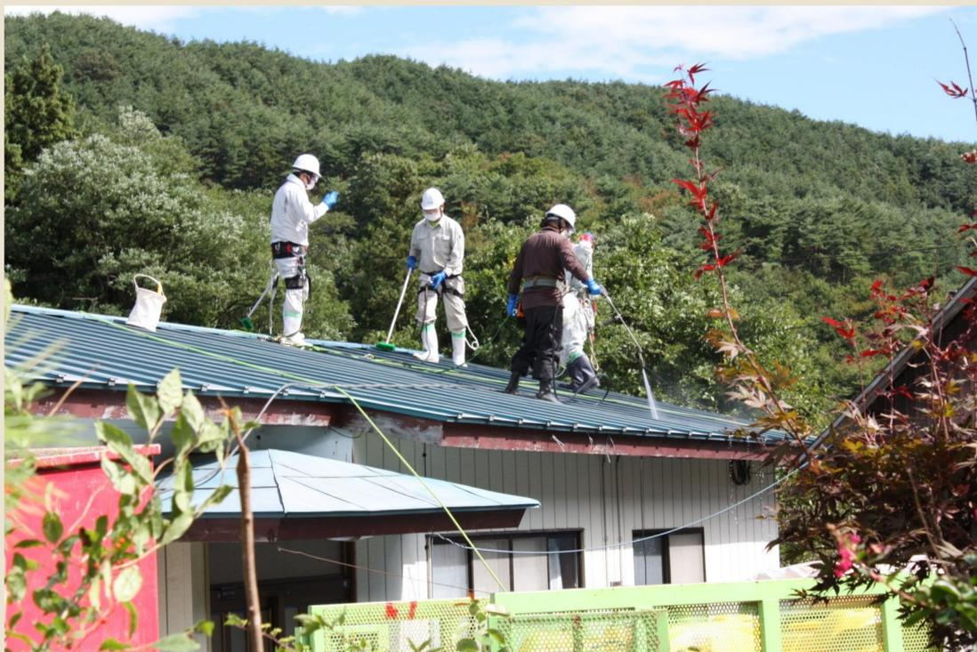
玉野地区住宅除染。洗浄した水は回収し、水処理装置で放射性物質と分離。安全な状態で排水している。
