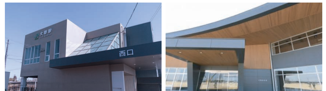
(左) 全線で運転が再開されたJR常磐線大野駅 (2022年2月)
