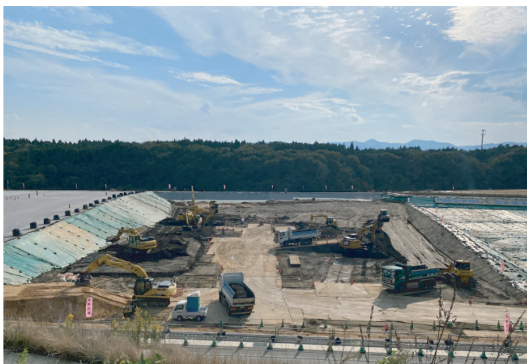
土壌貯蔵施設の様子(2021年10月)
