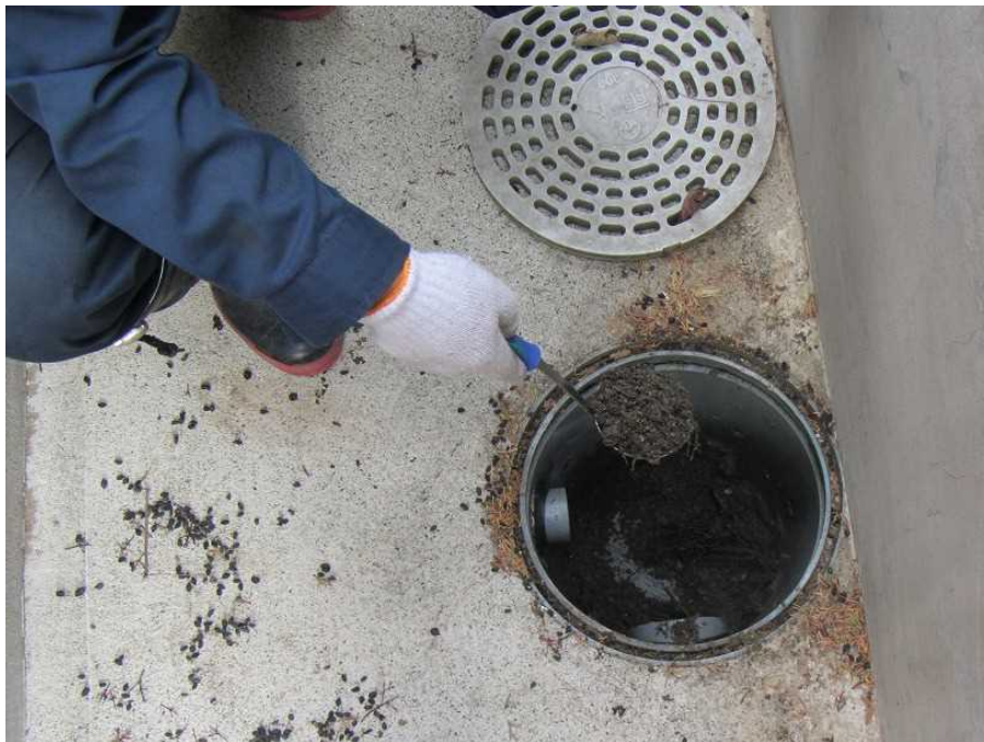
図 2-24 雨水枡の除染の例（堆積物の除去）
