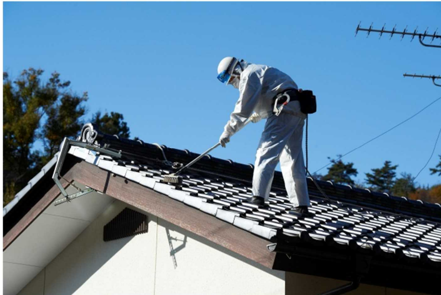
図 2-10 屋根の瓦の除染の例（洗浄）
