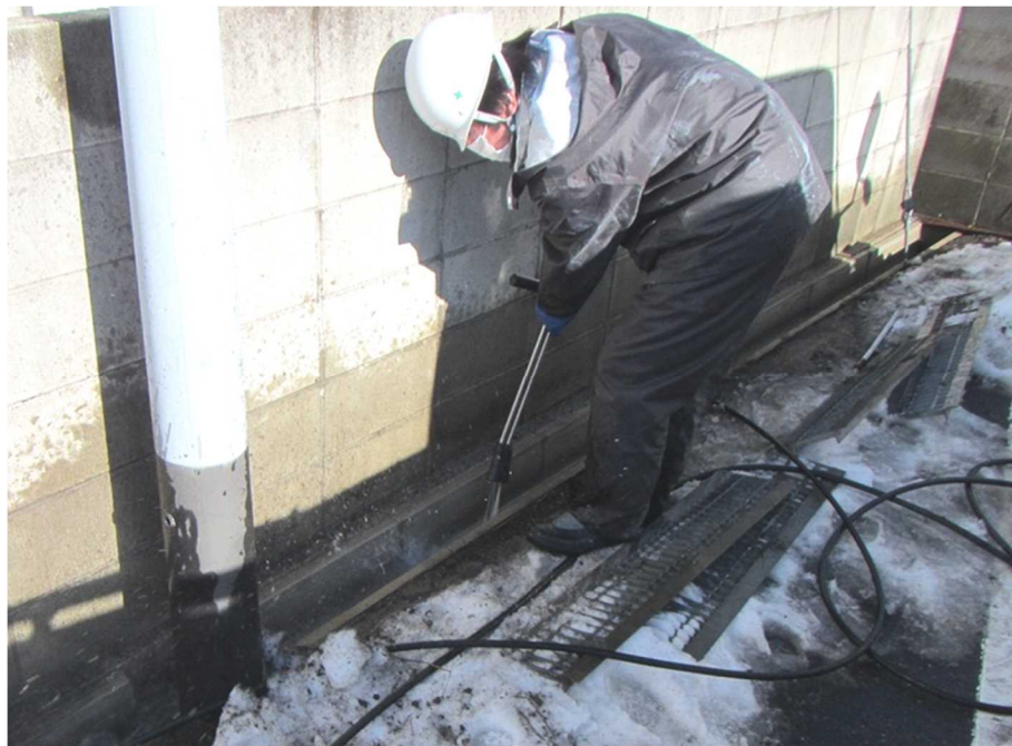
図 2-26 側溝の除染の例(高圧水洗浄)
