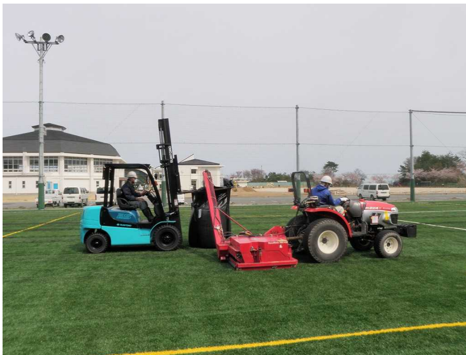
図 2-51 人工芝の充填材の除去の例
