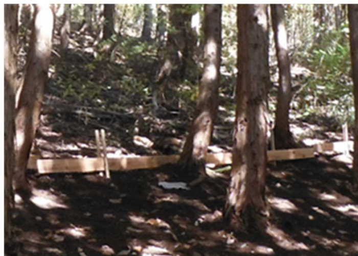
図 2-73 森林の除染等の措置の例（土砂流出防止対策）
