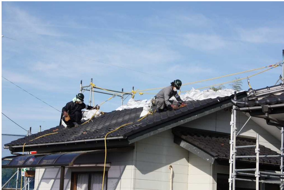
図2-9 屋根の瓦の除染の例（拭き取り）
