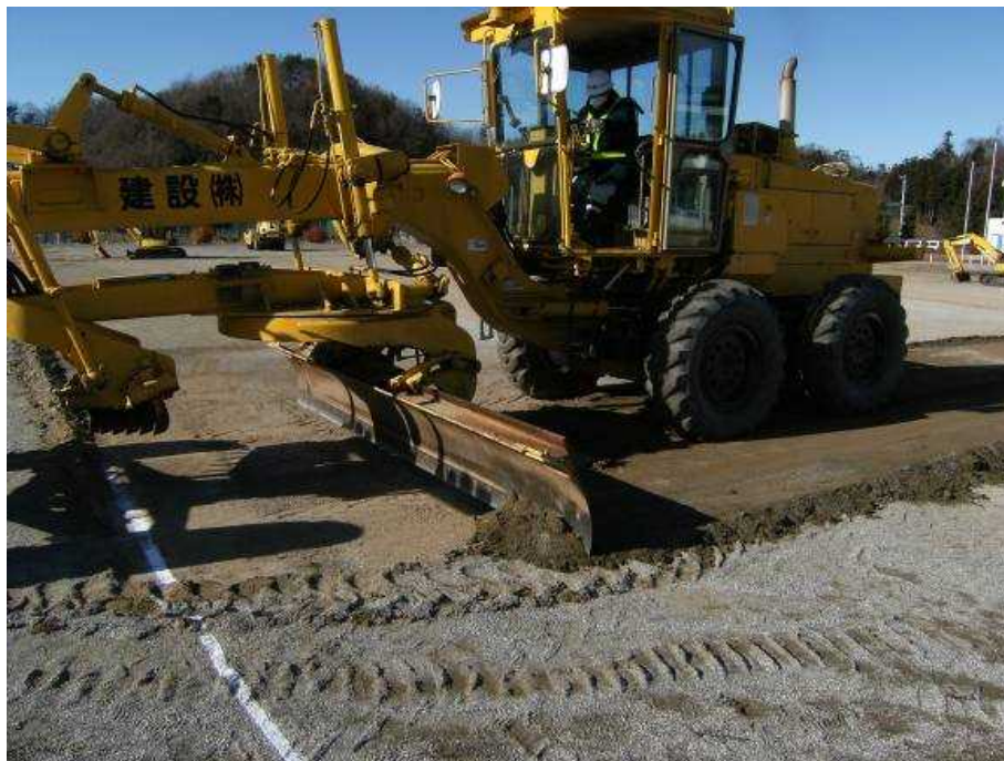
図 2-50 校庭の除染の例（表土の削り取り）
