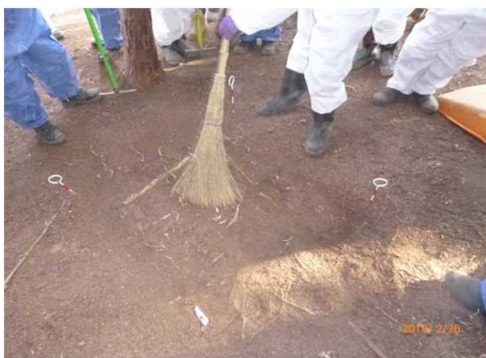
図 2-67 落葉等の堆積有機物除去の例
