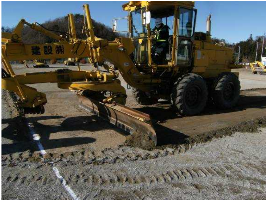
図 2-50 校庭の除染の例（表土の削り取り）
