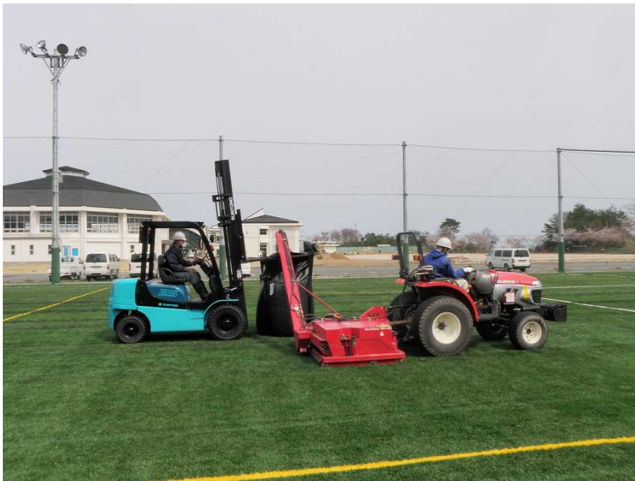
図 2-51 人工芝の充填材の除去の例
