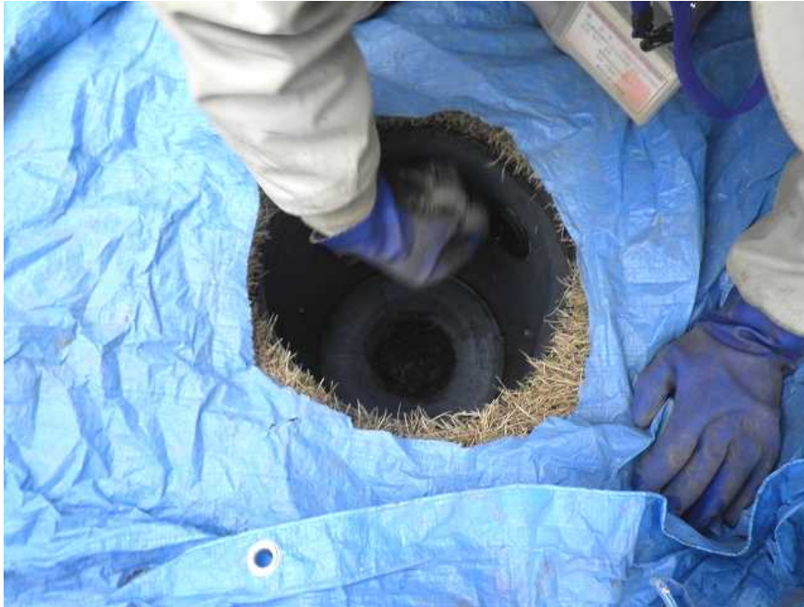
図2-27 雨水枡の除染の例（スポンジ洗浄）
