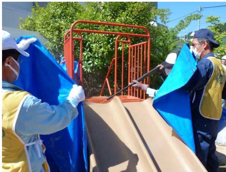
図 2-17 遊具の除染の例（高圧水洗浄）
