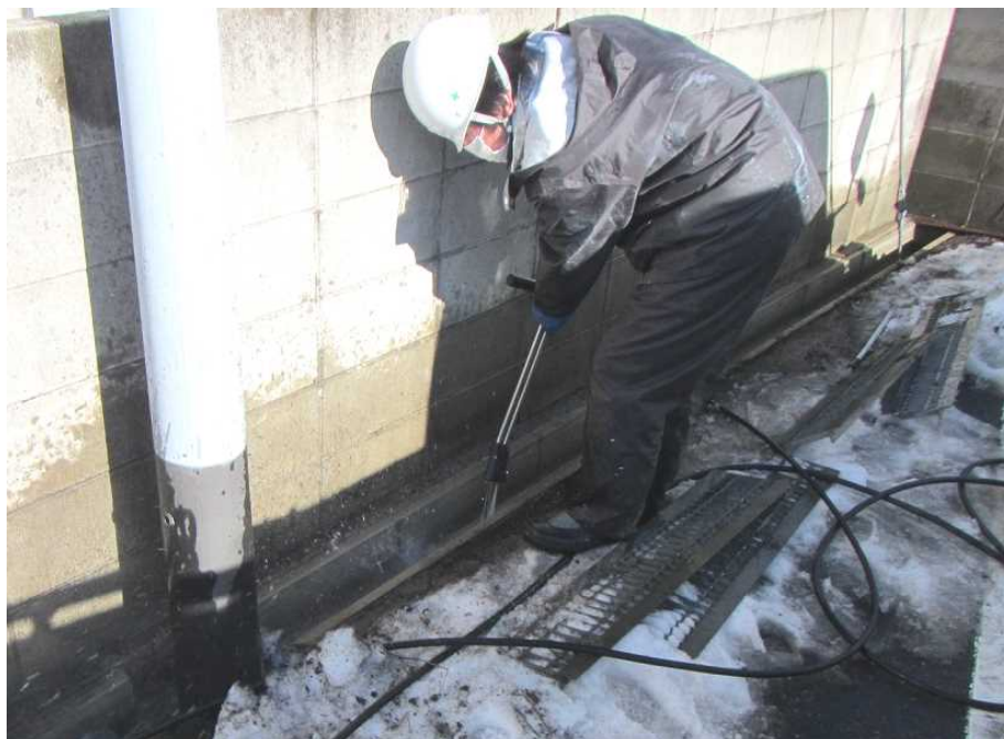
図 2-26 側溝の除染の例(高圧水洗浄)
