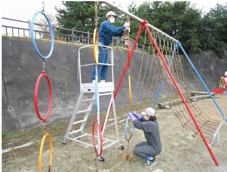
図 2-16 遊具の除染の例（拭き取り）
