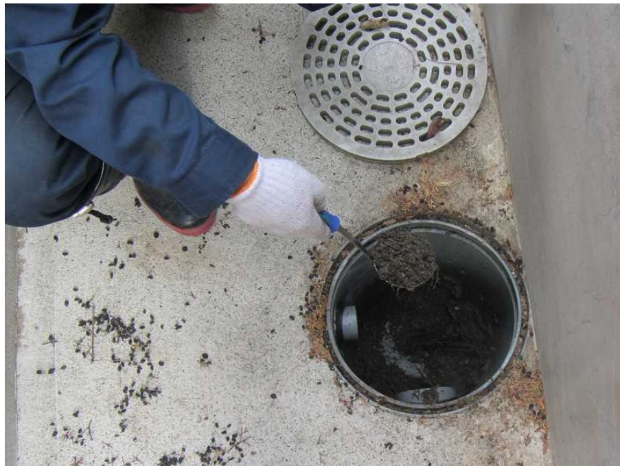
図 2-24 雨水枡の除染の例（堆積物の除去）
