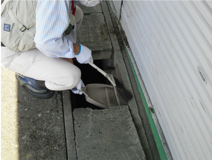
図2-41 側溝の除染の例（土、ほこりのはき取り）
