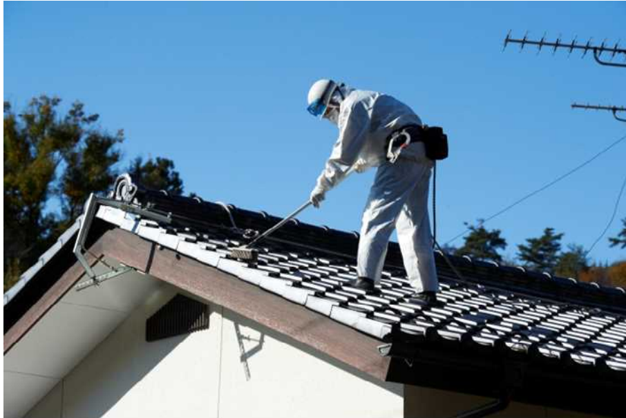
図 2-10 屋根の瓦の除染の例（洗浄）
