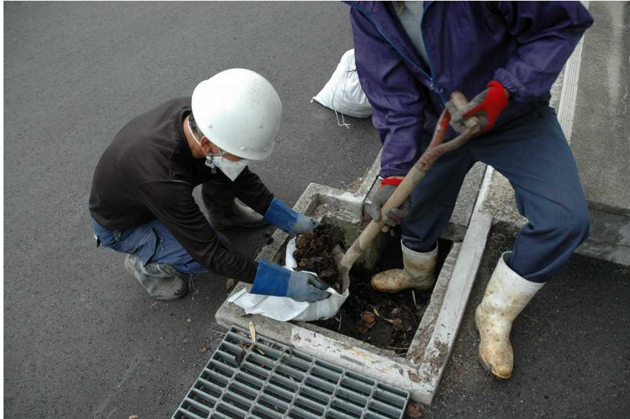
図 2-23 側溝の除染の例（堆積物の除去）
