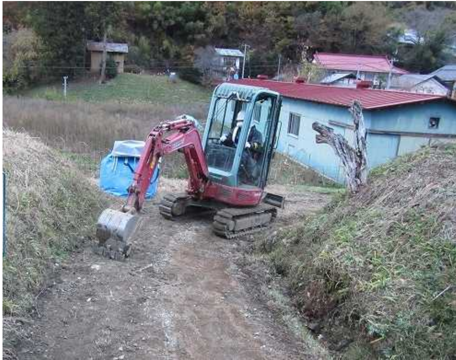
図 2-39 未舗装道路の除染の例（削り取り）
