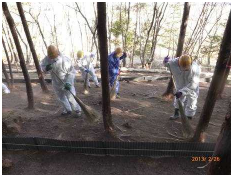
図2-66 森林の除染の例（堆積有機物残さ除去）
