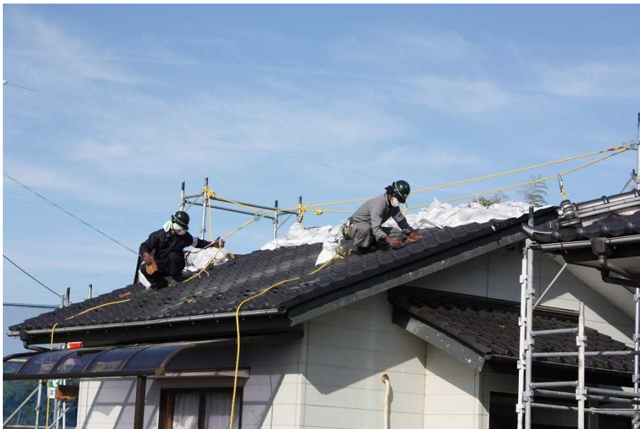
図2-9 屋根の瓦の除染の例（拭き取り）
