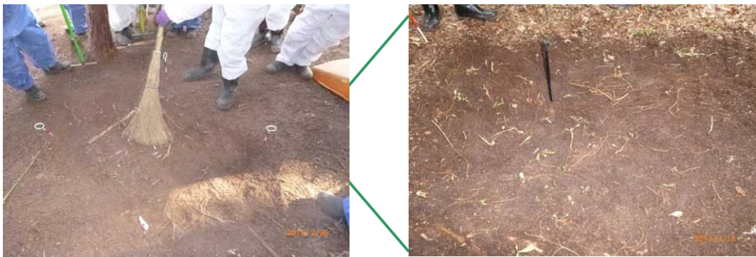
堆積有機物の除去の後に、竹箒*により残さを除去。 *先端20cm程度をカットし弾力性を確保したもの。
