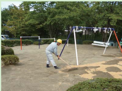
つち けず と 土の削り取り
