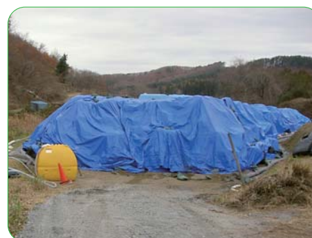
⑦ 山積みが完了し、ブルーシートなどで覆います。
