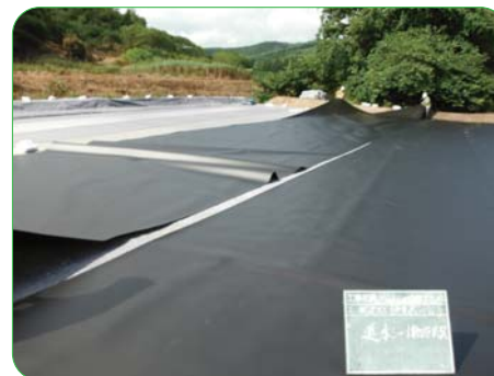
③ 防水シートなどを敷きます。
