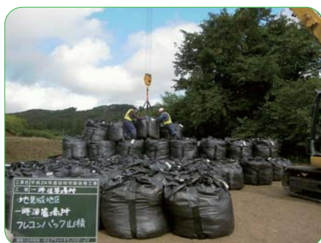
⑥ 取りのぞいた土などがいったフレキシブルコンテナや大型土のうなどを搬入します。
