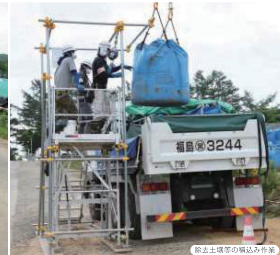
除去土壌等の積み込み作業
