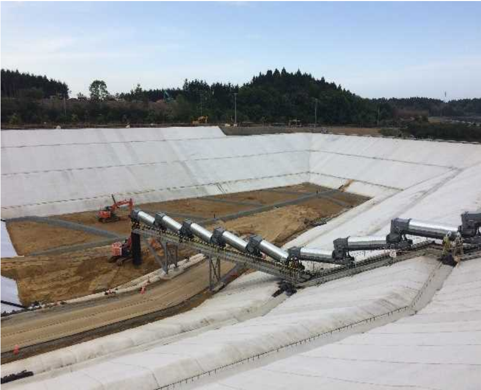
貯蔵区画の全景
