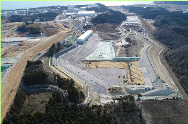
大熊 2 期③工区土壌貯蔵施設（2019. 3. 26撮影） 2019年 3 月の貯蔵量：約1.5万 \text{m}^3 （累計約5.8万 \text{m}^3 ）
