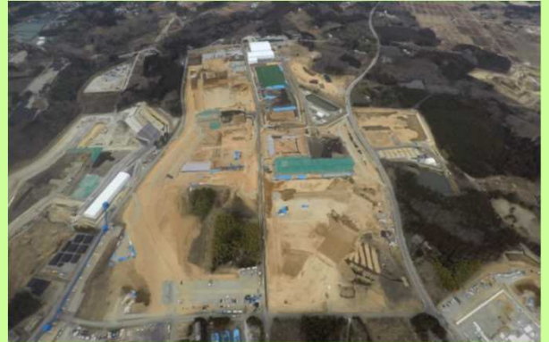
大熊 1 期②工区及び 2 期②工区土壌貯蔵施設 （2019. 2. 18撮影） 2019年 3 月の貯蔵量（第 1 期施設/第 2 期施設） ：約1.4万 \text{m}^3 /約2.5万 \text{m}^3 （累計約12.5万 \text{m}^3 /約14.4万 \text{m}^3 ）
