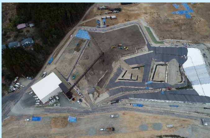
双葉 2 期①工区土壌貯蔵施設（2019. 3. 22撮影） 2019年 3 月の貯蔵量：約0.3万 \text{m}^3 （累計約4.0万 \text{m}^3 ）
