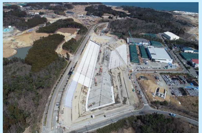
双葉 2 期②工区土壌貯蔵施設（2019. 3. 18撮影） 建設中
