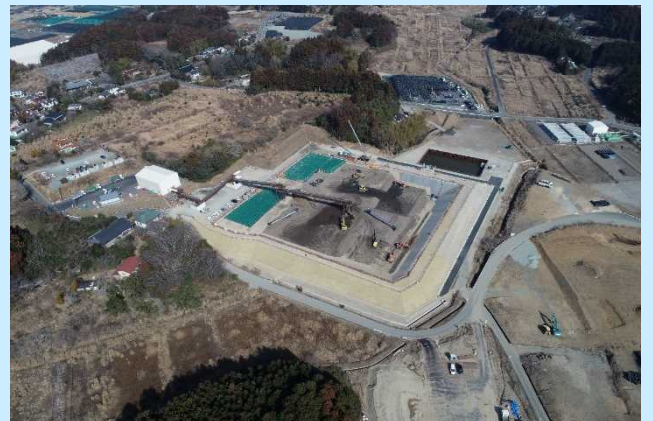
双葉 1 期①工区土壌貯蔵施設（2019. 2. 26撮影） 2019年 3 月の貯蔵量：約0.7万 \text{m}^3 （累計約3.4万 \text{m}^3 ）
