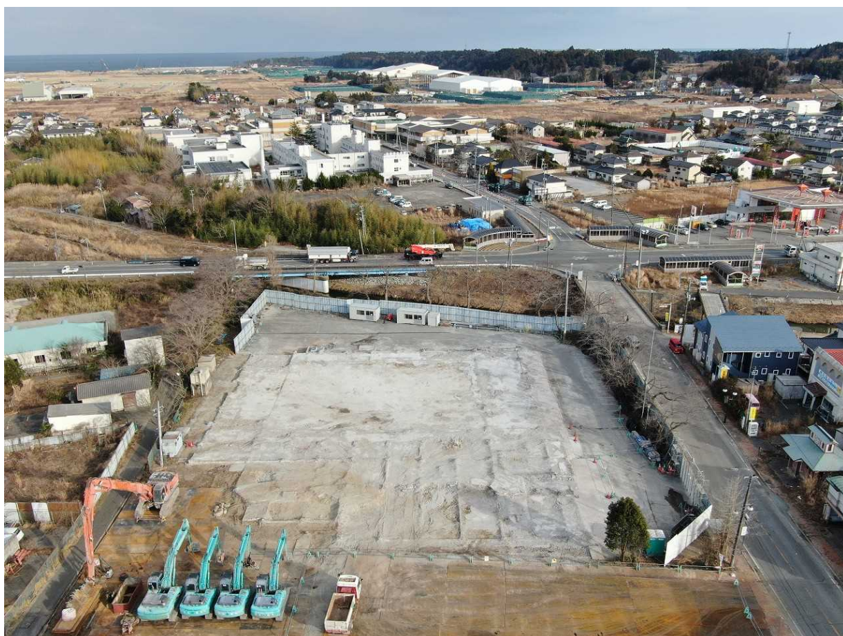
建物部分解体完了
