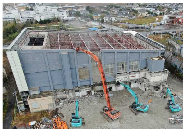
解体着手状況
