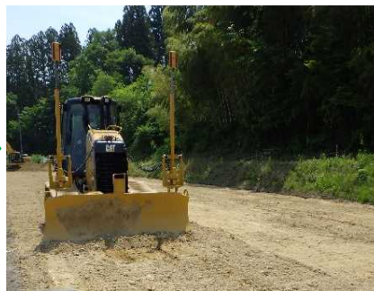
原状回復作業(客土敷均し)
