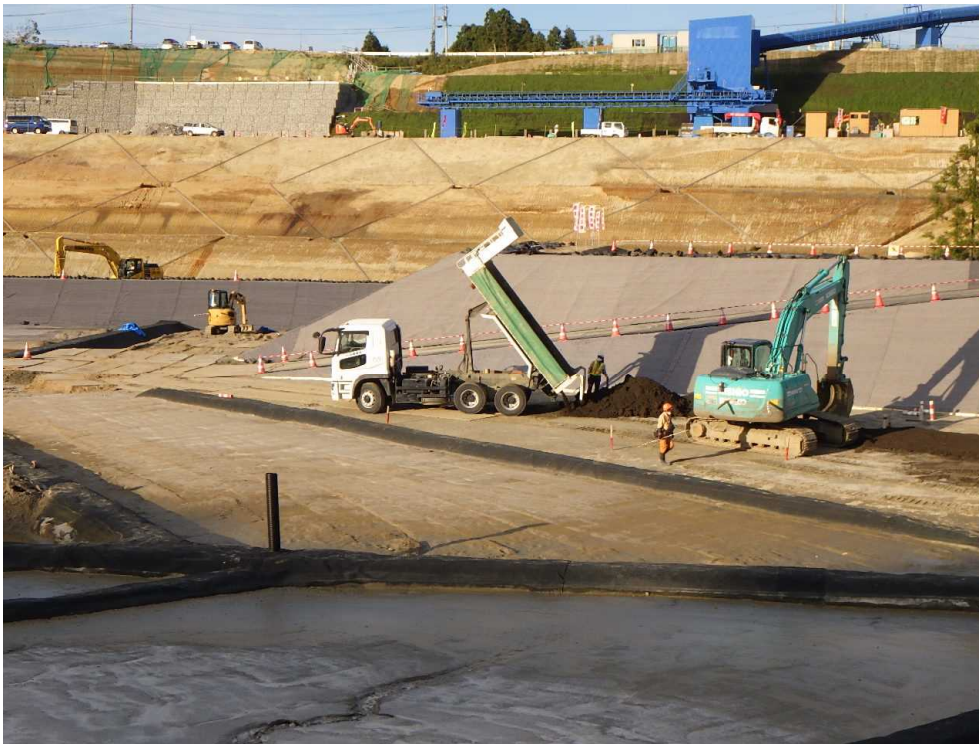
土壌貯蔵施設内に土壌が運び込まれた様子
