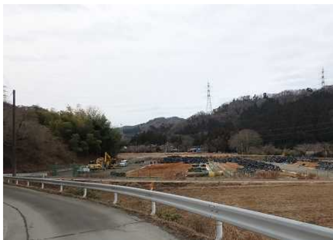
原状回復工事着手前の 仮置場全景
