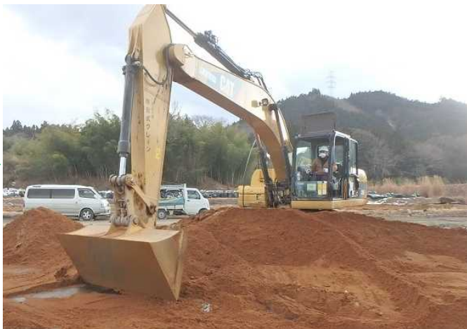
敷砂土砂の撤去
