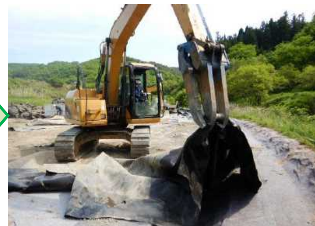
現場発生材の撤去 （下部シートの撤去）
