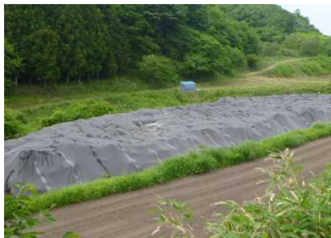
搬出前の仮置場全景
