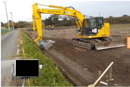
地力回復材の散布・耕起
