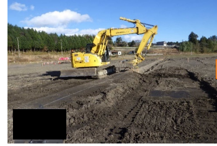
地力回復材の散布・耕起
