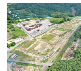
農地盛土造成 (3工区)
