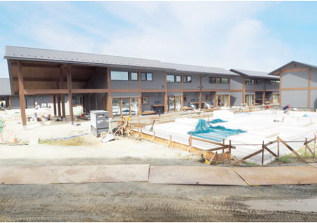
建設中の「駅西住宅」
