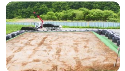
盛土完成後の様子
