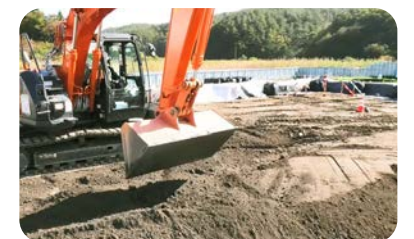
盛土の施工の様子
