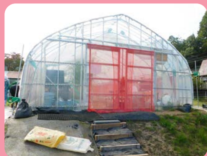
ビニールパイプハウス
