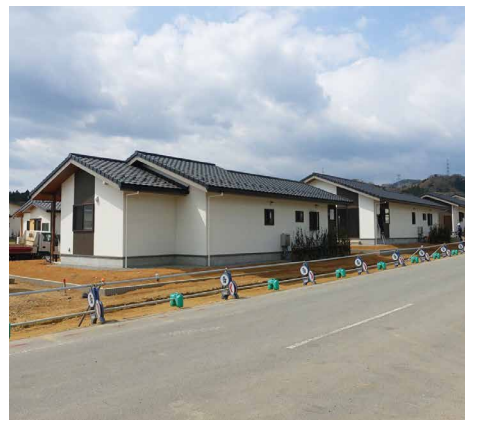
建設が進む公営復興住宅
