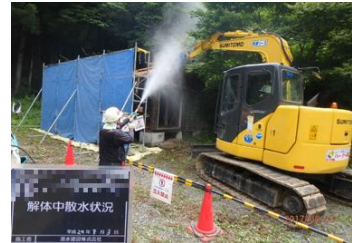
被災家屋等の解体の様子
