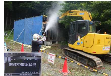
被災家屋等の解体の様子
