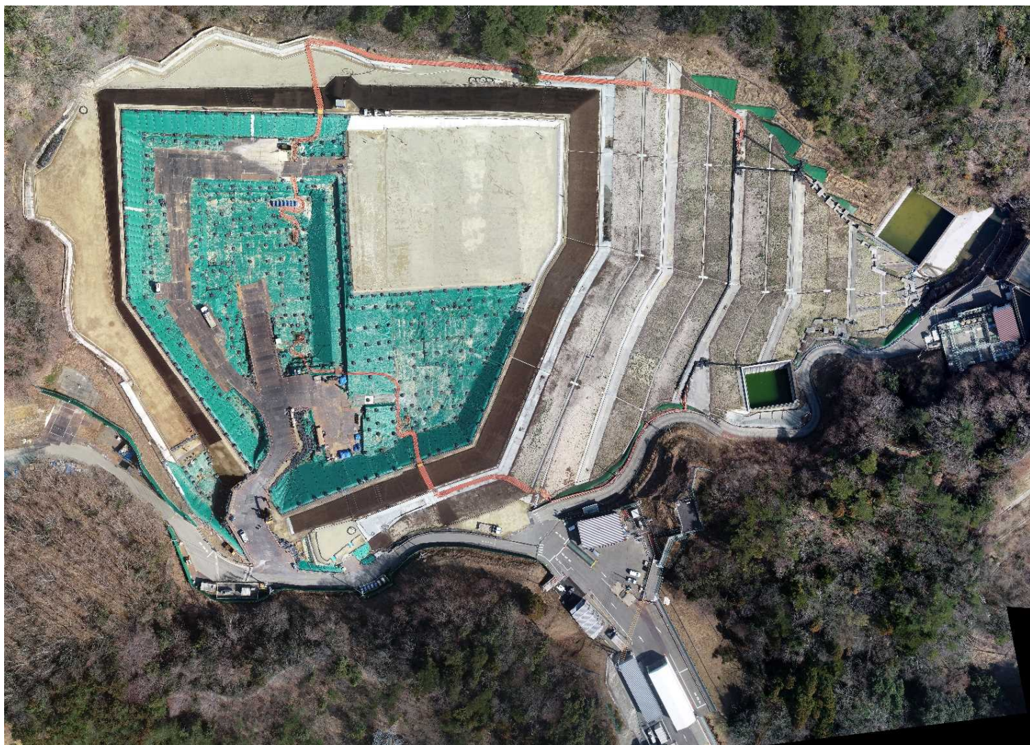
特定廃棄物埋立処分施設（2024年3月15日撮影）
