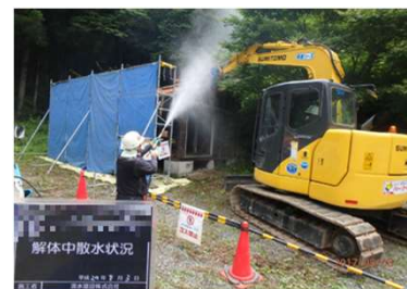
被災家屋等の解体の様子
