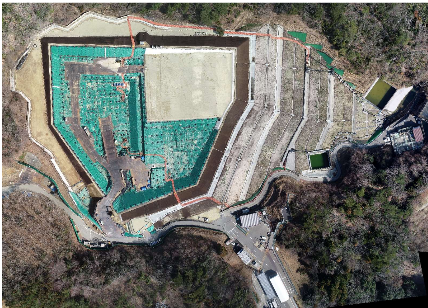
特定廃棄物埋立処分施設（2024年3月15日撮影）
