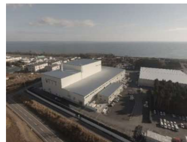
大熊町の仮設焼却施設
