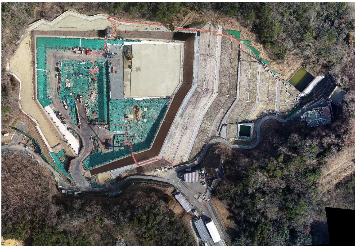
特定廃棄物埋立処分施設（2024年2月15日撮影）
