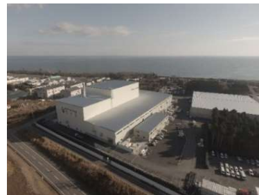
大熊町の仮設焼却施設
