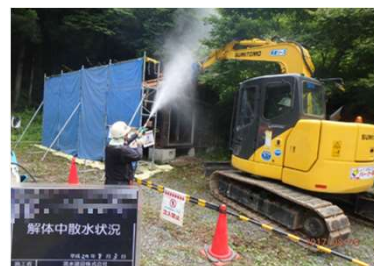
被災家屋等の解体の様子
