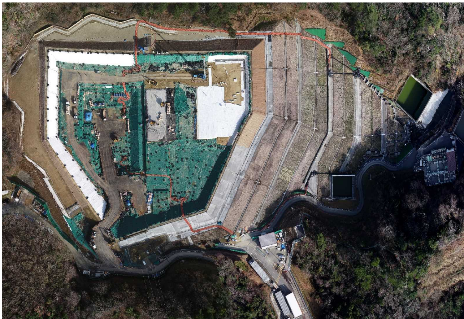
特定廃棄物埋立処分施設（2023年12月19日撮影）
