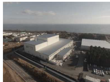
大熊町の仮設焼却施設
