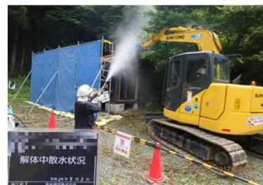
被災家屋等の解体の様子
