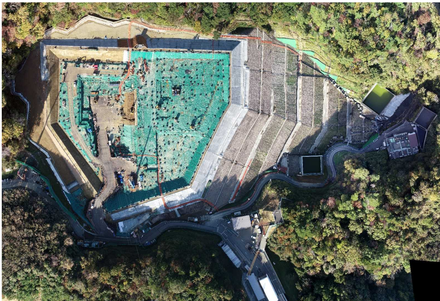
特定廃棄物埋立処分施設（2023年11月16日撮影）
