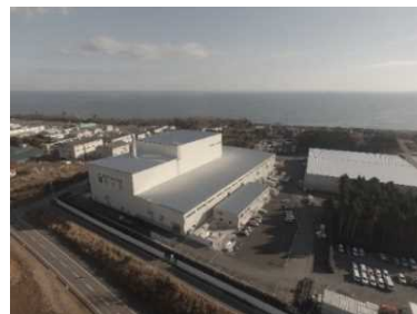
大熊町の仮設焼却施設
