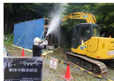
被災家屋等の解体の様子
