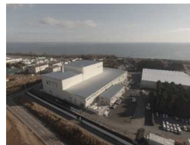
大熊町の仮設焼却施設
