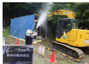
被災家屋等の解体の様子
