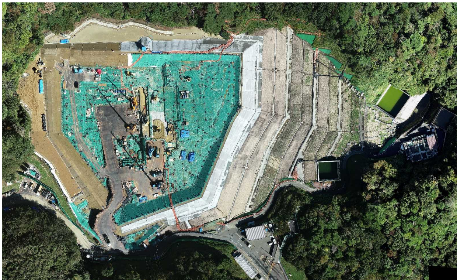
特定廃棄物埋立処分施設（2023年10月16日撮影）
