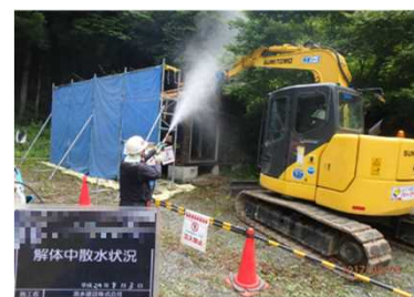
被災家屋等の解体の様子
