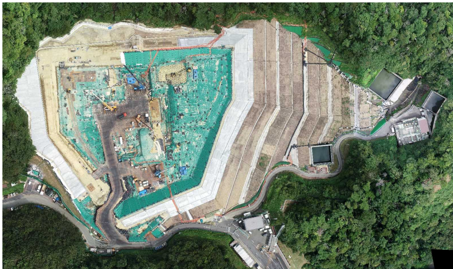
特定廃棄物埋立処分施設（2023年9月15日撮影）
