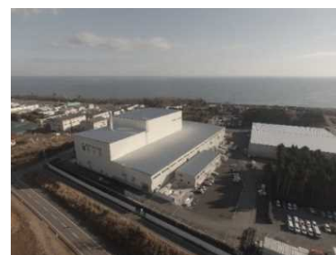
大熊町の仮設焼却施設
