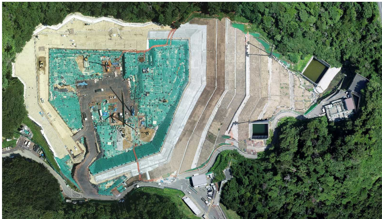
特定廃棄物埋立処分施設 （2023年8月21日撮影）
