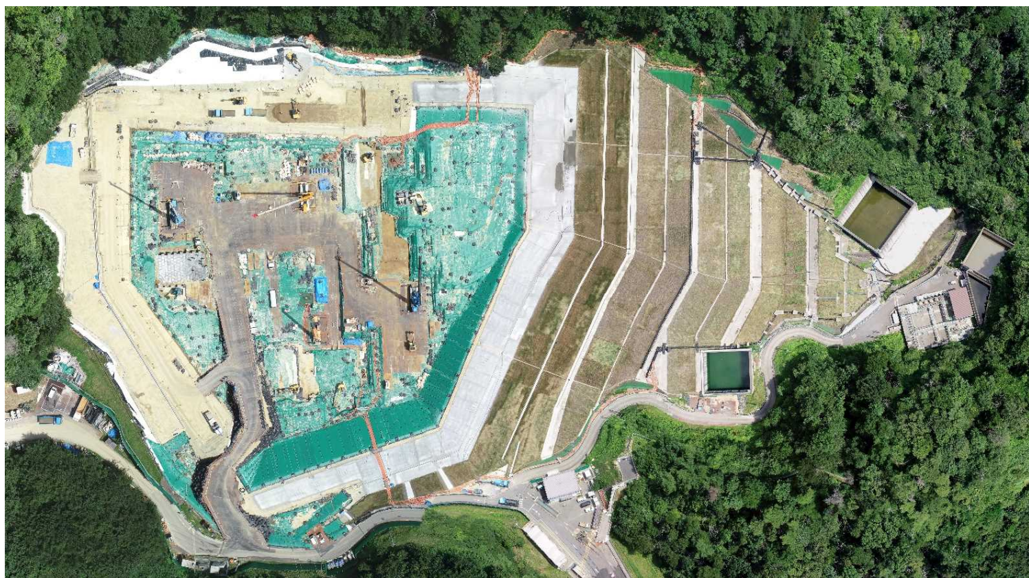
特定廃棄物埋立処分施設（2023年7月18日撮影）
