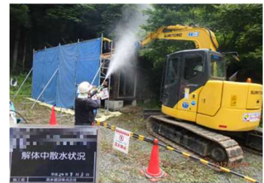
被災家屋等の解体の様子
