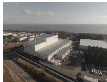
大熊町の仮設焼却施設
